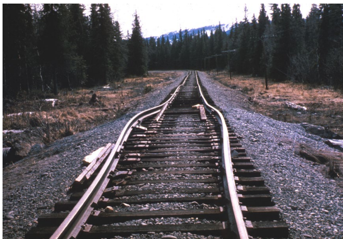
Rys. 1. Przykład zdeformowanej infrastruktury kolejowej
