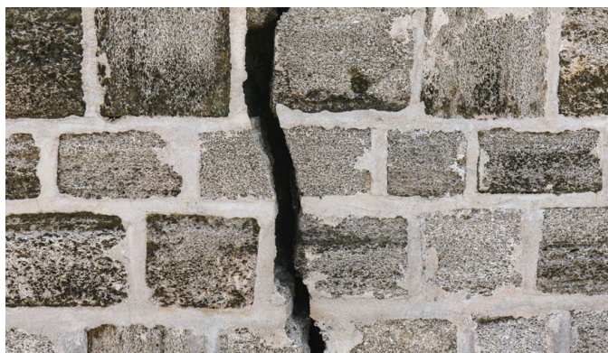
Rys. 2. Pęknięcia elementów konstrukcyjnych ścian nośnych.
